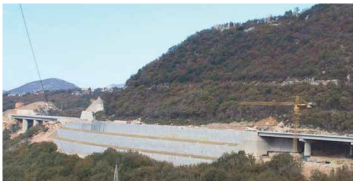
↓ Pogled na konstrukciju od armiranog tla Sv. Trojica tijekom izgradnje.
