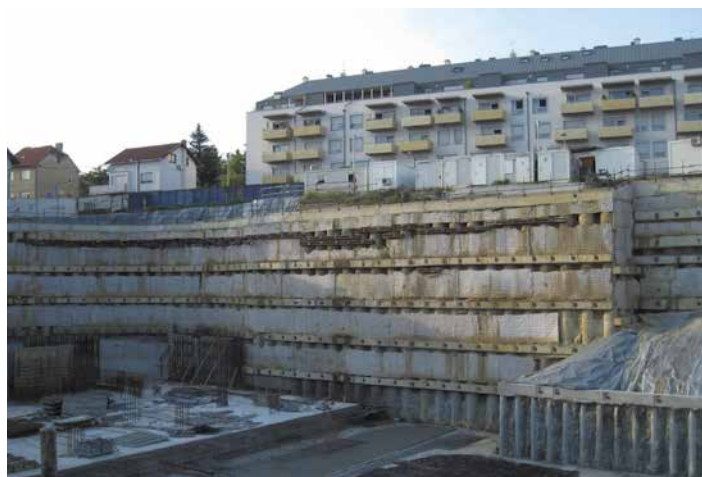
↑ Pogled na građevnu jamu za dnevnu bolnicu Sv. Duh (snimljeno 9. 5. 2018.)
