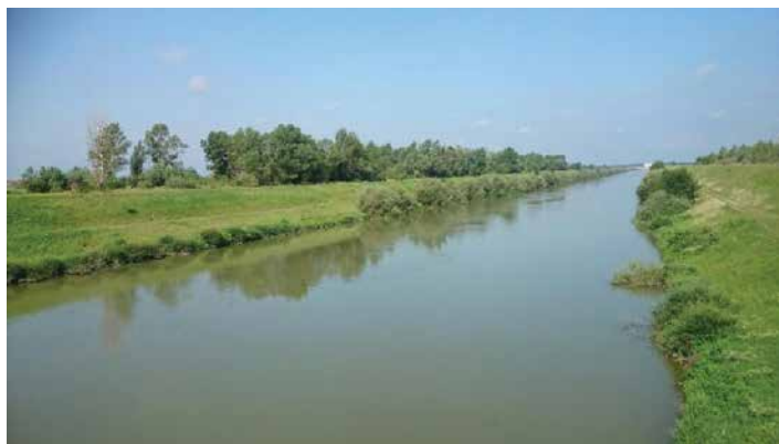
↓ Odvodni kanal HE Varaždin
