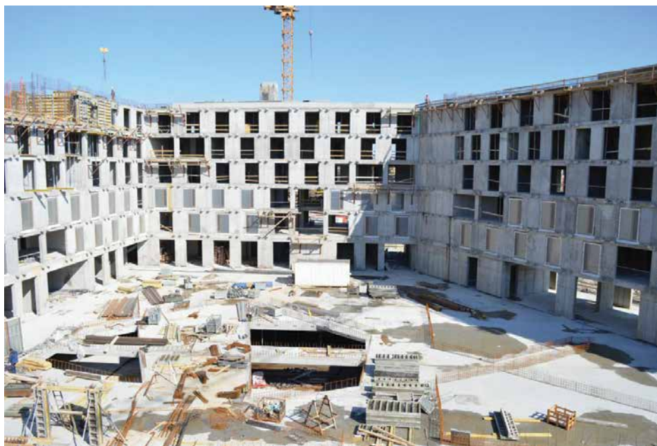
← Studentski dom detalj s gradilišta
