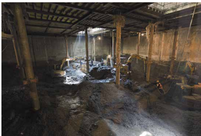
↑ Iskop ispod stola i čelični stupovi (sa stranica UPI2M)
