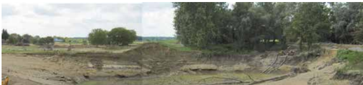
↓ Oštećeni nasip kod Rajevog Sela nakon poplave
