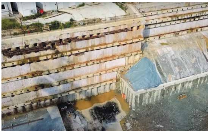
↑ Pogled na građevnu jamu za dnevnu bolnicu Sv. Duh (snapshot HKIG, 2021.)
