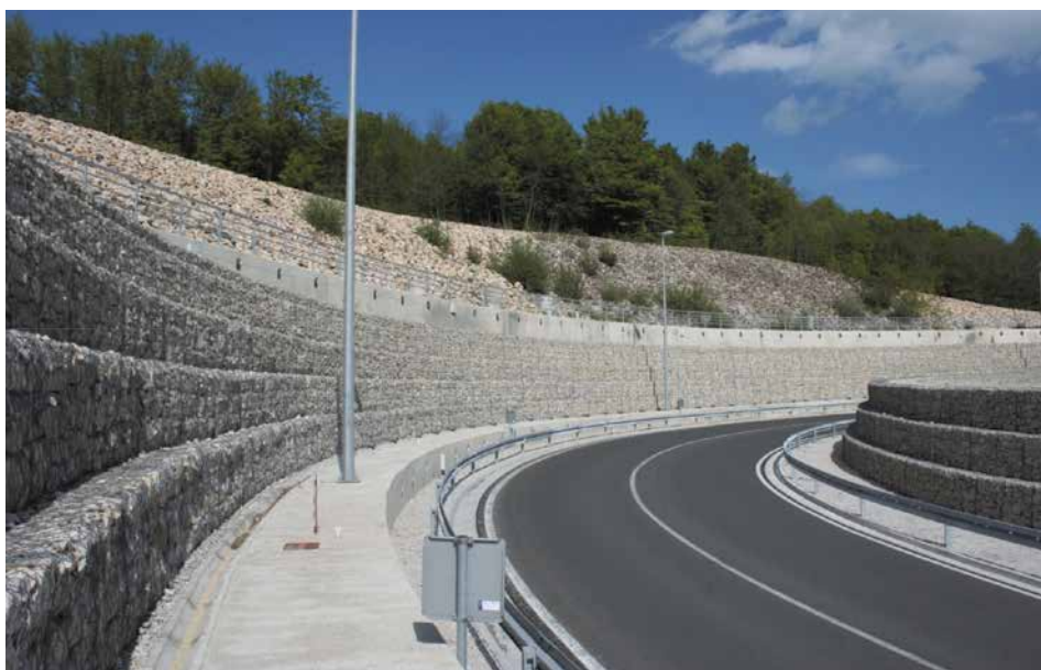
↓ Pogled na dio izvedene konstrukcije
