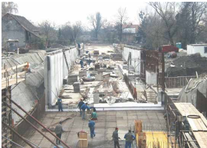
↑ Shema zaštite građevne jame na adresi Savska cesta br. 32 ispod željezničke pruge i pogled prema zaštiti građevne jame; vidljiva je zgrada Cibone s druge strane pruge
