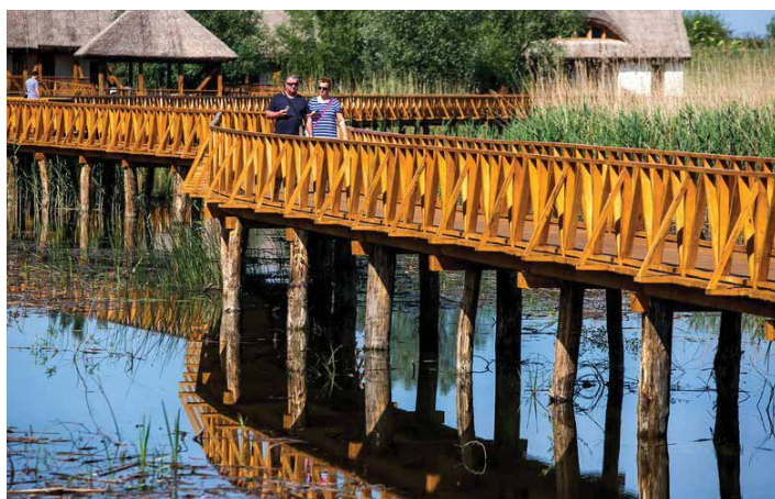
↑ Novi, originalni drveni most kroz Kopački rit
