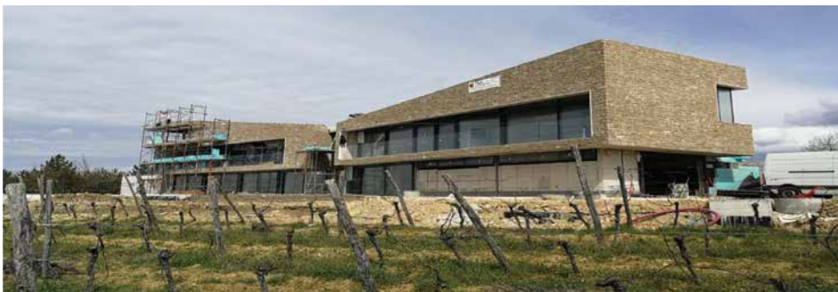
← Obilazak gradilišta obiteljske kuće iznad Grožnjana
